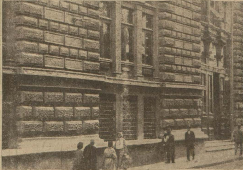
İnhisarlar İdaresinin Galatadaki Umumi Müdürlük binası
